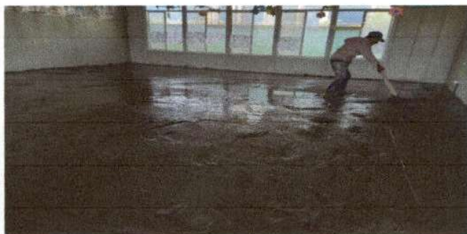
Foto 3: Albañil nivelando la fundición de las aulas
