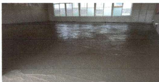
Foto 6: Alisado del piso por el constructor de las 5 aulas
