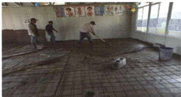
Foto1: Fundición de piso en una de las 5 aulas y Banquetas
