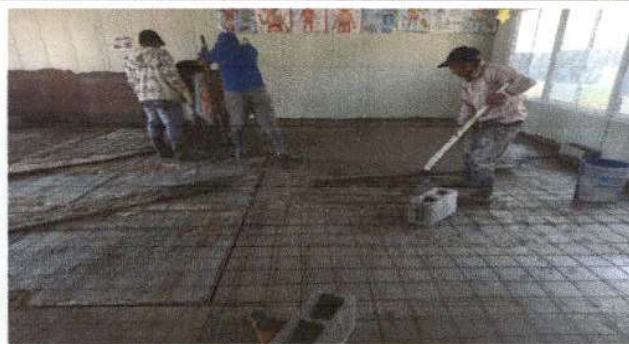
Foto 4: Padres de familia colaborando en la fundición del piso de las 5 aulas.
