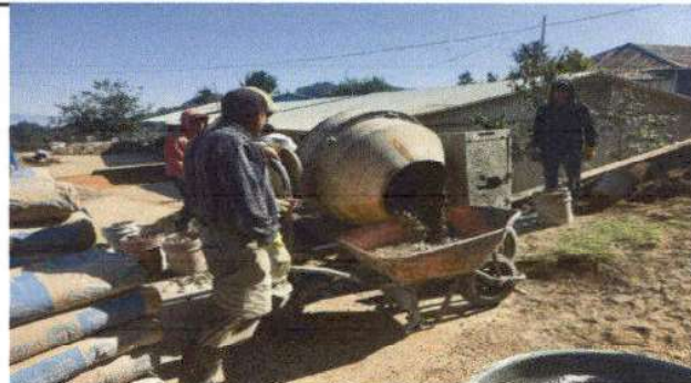
Foto 2: Preparación de mezcla para fundición de piso de 5 aulas y banquetas
